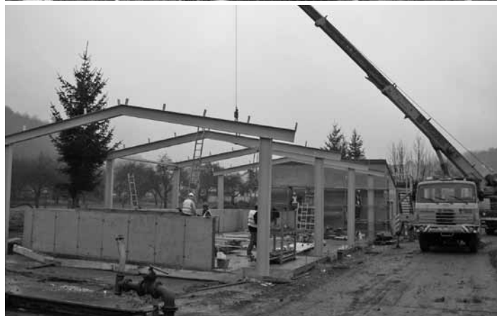
· Rekonstrukce čistírny odpadních vod ve Květné
