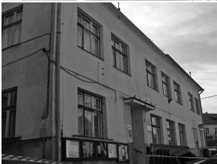
· Rekonstrukce obecního úřadu
