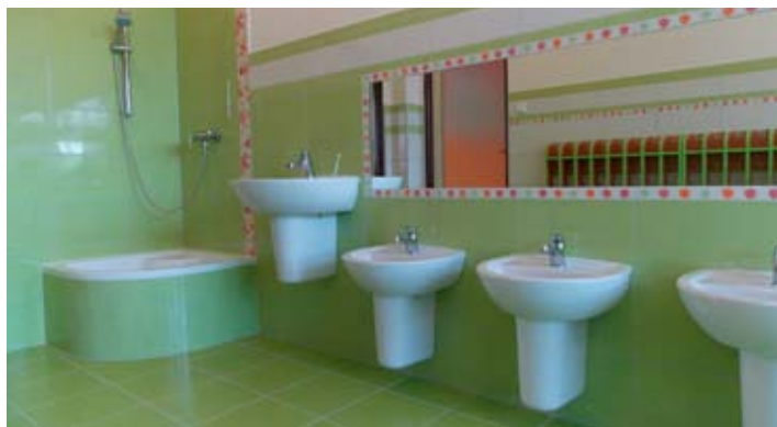
MŠ Květná - celková rekonstrukce soc. zařízení
