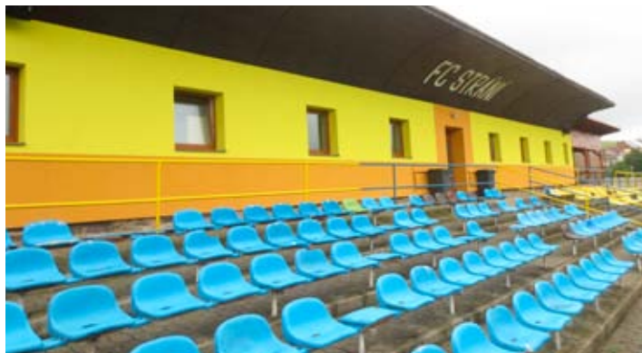
Zateplení fasády a výměna oken na fot. kabinách
