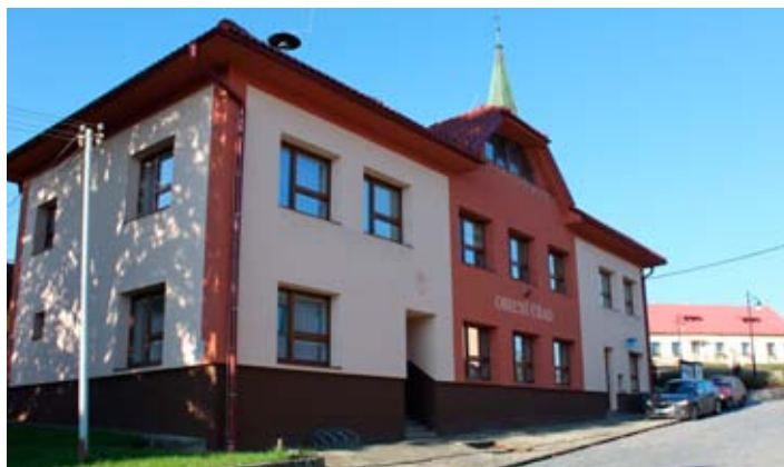
Rekonstrukce Obecního úřadu
