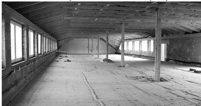
Prostor půdní vestavby nad šatnami ZŠ před rekonstrukcí
